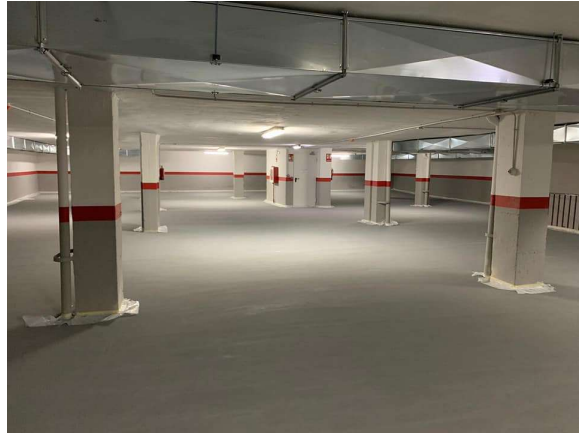
2: Aplicación capas Resiepox
